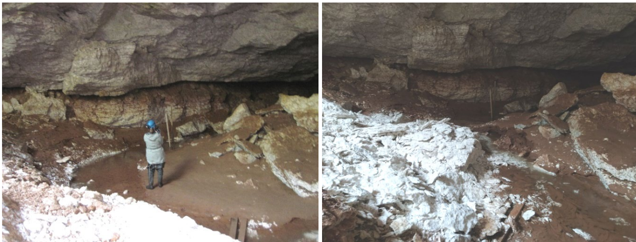
Рисунок 4.1-3 Состояние свода в пещере Певческая Эстрада (Г-1) в августе 2021 года за день до обрушения (слева); зона обрушения и размыв левого берега ручья (справа)
