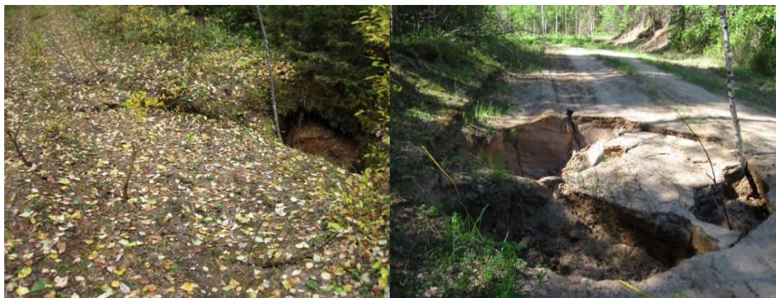
Рисунок 4.1-6 Просадка на дороге в логу Голубинском (слева); сложная строенная провальная форма на дороге на Войван (справа)
